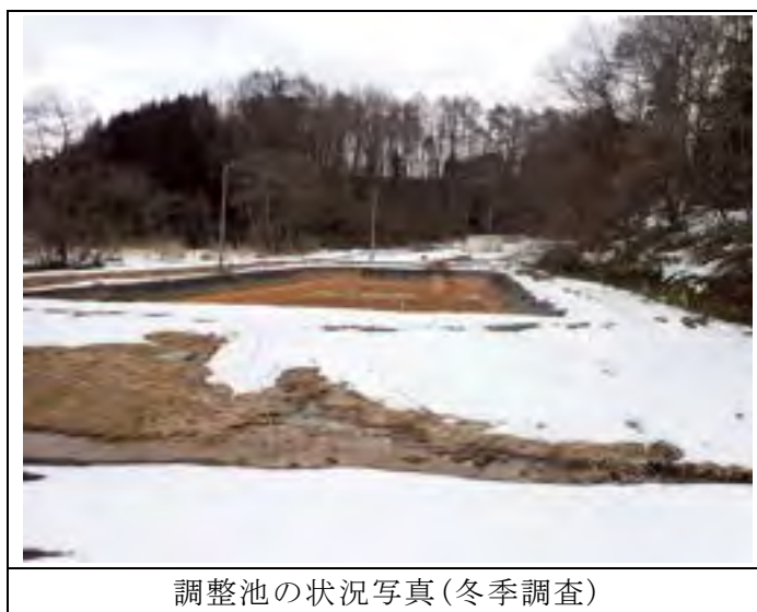
図 6.11-5 調整池の状況
